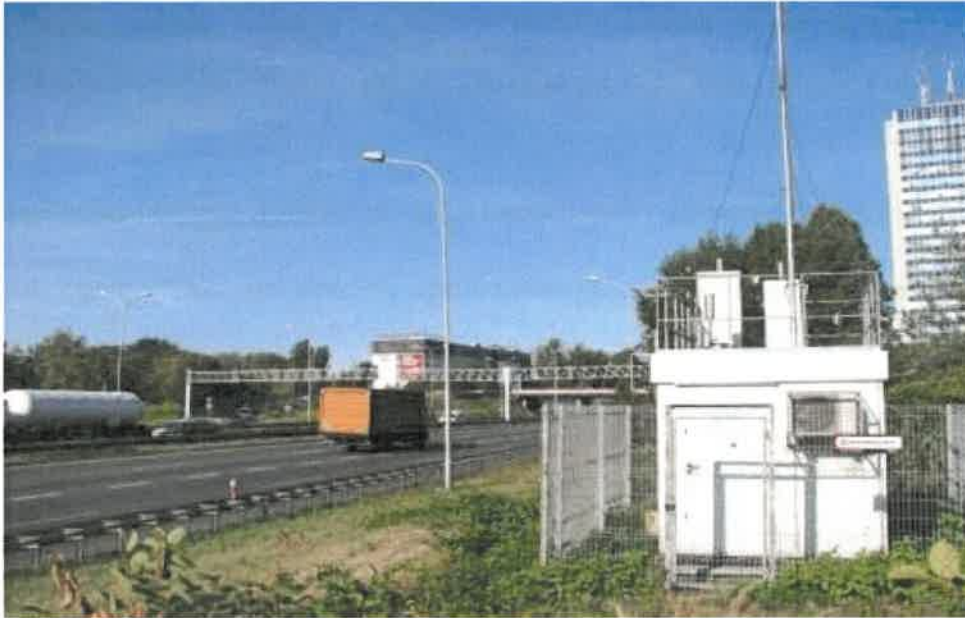
Rysunek 8. Stacja monitoringu - ul. Plebiscytowa w Katowicach
